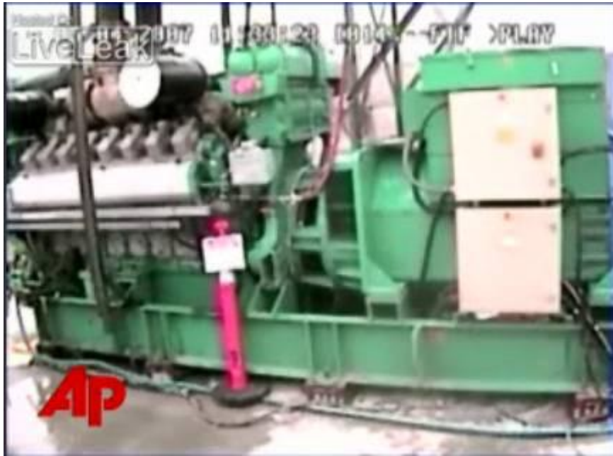
Figura 10. Video realizzato dall'Idaho National Lab 46 su commissione del DHS che evidenzia come un attacco cyber sia in grado di distruggere fisicamente una turbina 47 .
